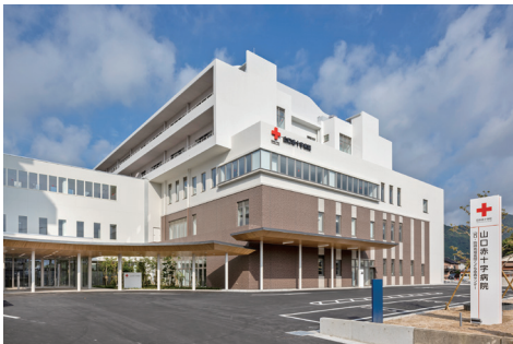
正面から見た北病棟
